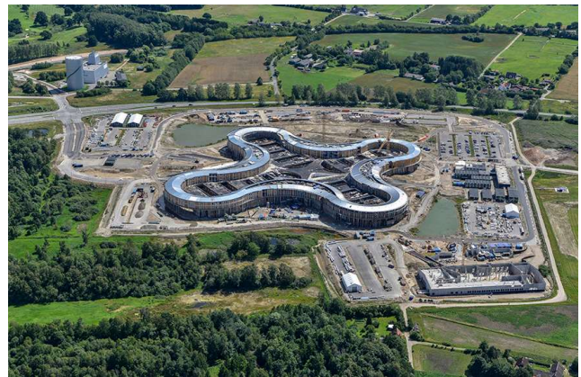
Byggeplads for Nyt Hospital Nordsjælland, juli 2023.
