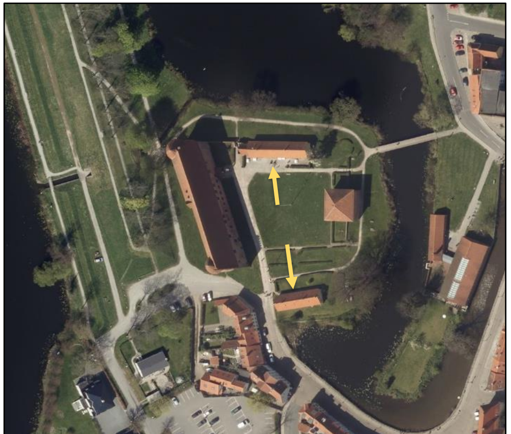
Figur 10-17 Oversigtskort fra 2016 viser de to nedrevne bygninger (gule pile). Kilde COWI MultiViewer.
