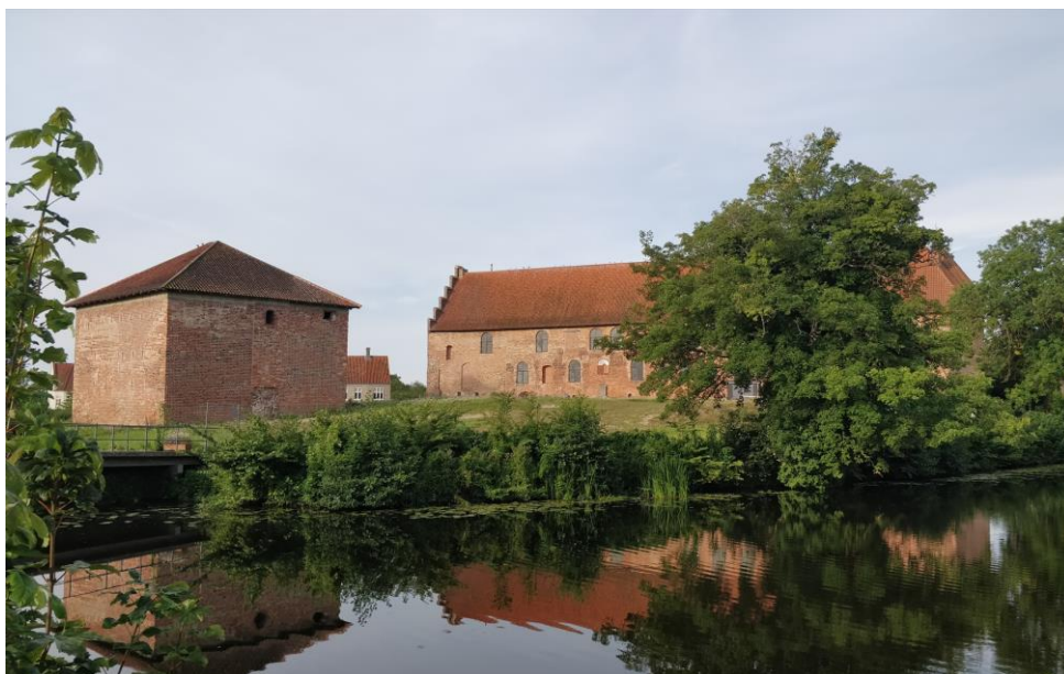
Figur 10-4 Slottet og voldgraven set fra nordøst (foto fra besigtigelse).
