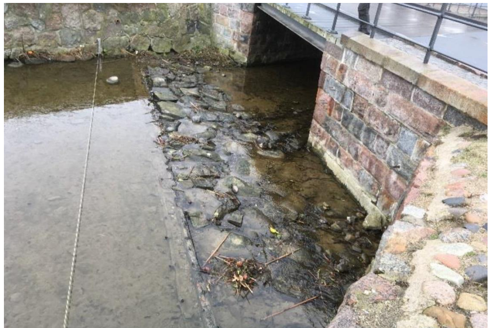
Figur 11-2 Opstemningskant i Voldgraven ved Torvet ved st. 1.264 m. Det er denne kant, der ønskes hævet med vandspejl til kote 3,75 m (Bangsgaard & Paludan ApS., 2019).
