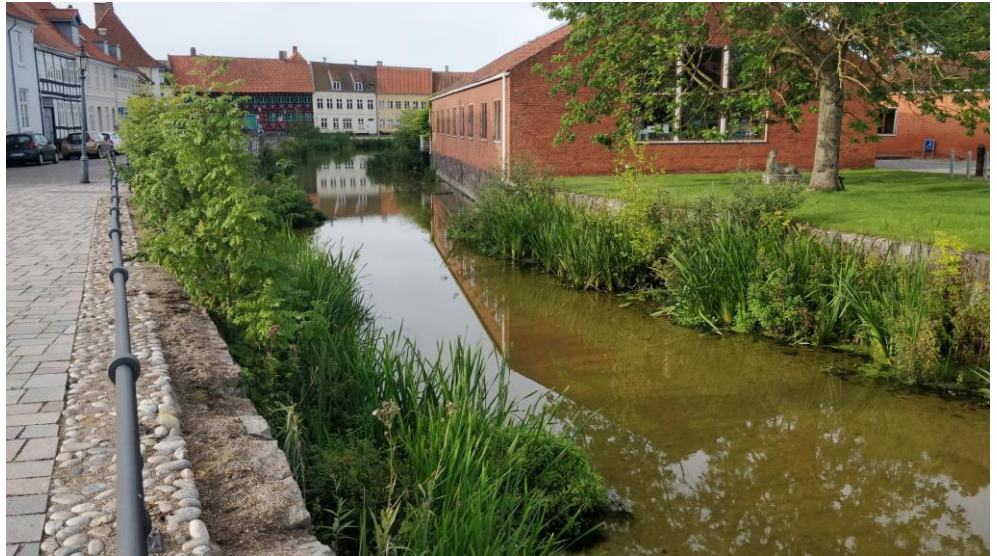
Figur 10-5 Vandløbets kanaliserede forhold ved udløbet bag ved Biblioteksholmen (foto fra besigtigelse).
