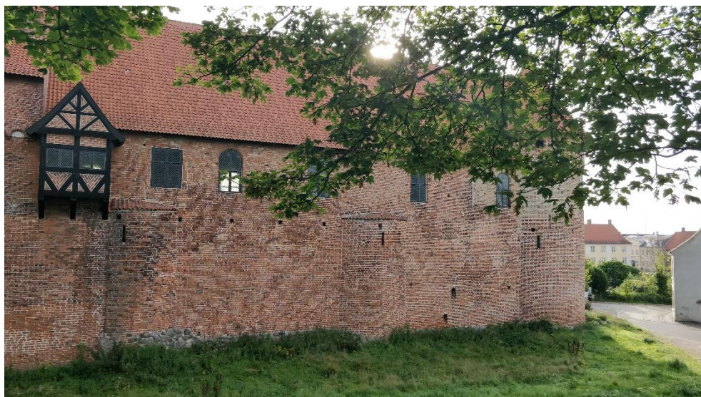
Figur 8-1 Kongefløjen set fra vest, Slotsgade ses til højre i billede. Foto COWI.
