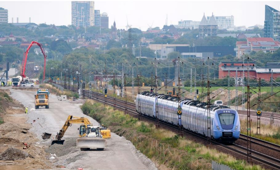
Arbete på sträckan Malmö–Lund år 2020 för bygge av fyra spår i stället för dubbelspår. Foto: Johan Nilsson/TT
