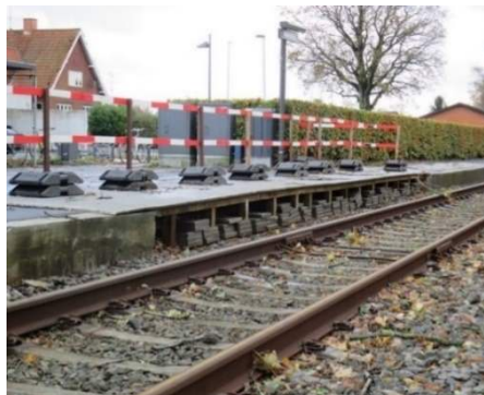
Figur 12 Tilstandskritisk perron
