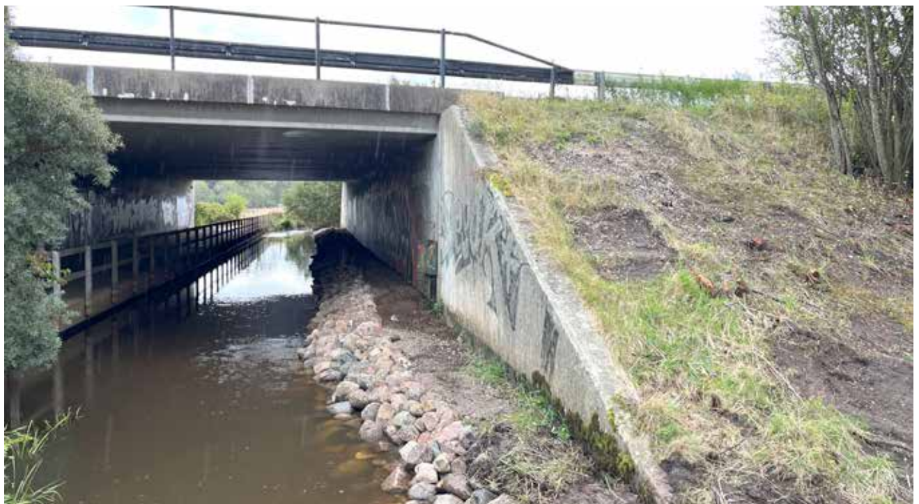
Eksempel på faunapassage med vandløb for små og mellemstore dyr langs vandløb eksempelvis odder.
