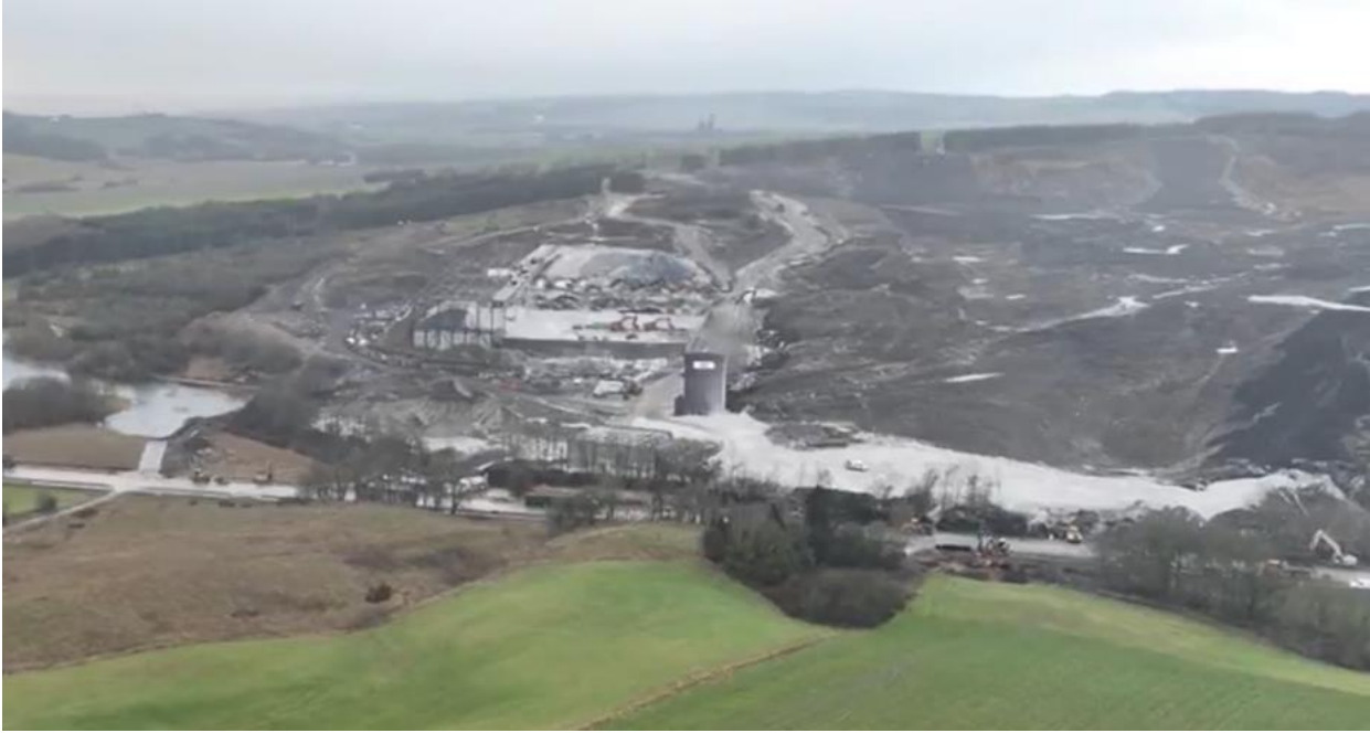
Figur 1. Nordic Waste deponerede gennem årene i størrelsesordenen 4 Mt jord, inden det gik galt. Det skønnes, at 3 Mt jord har sat sig i bevægelse. Til sammenligning ønsker CO2 Storage Kalundborg at deponere 12 Mt CO2 om året.
