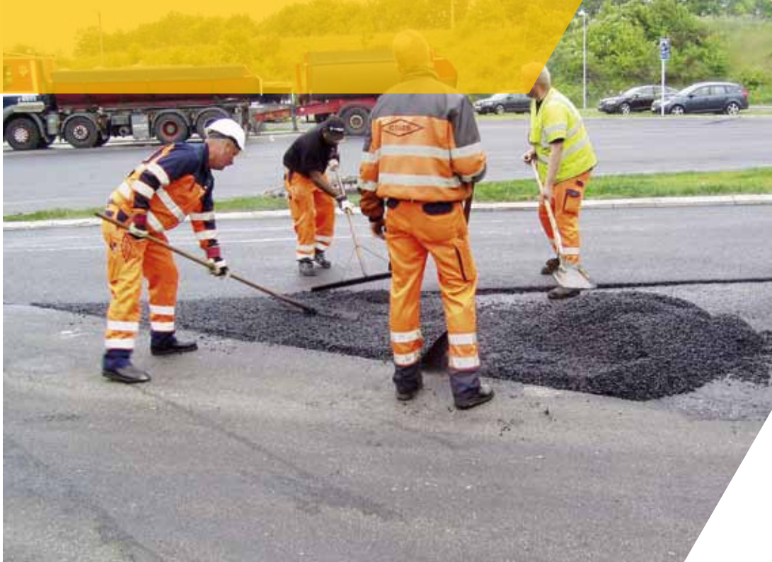
Figur 11 Håndarbejde udføres ved udlægning af SMA 11 ROAD+ 15 % på rastepads Himmerland Øst.
