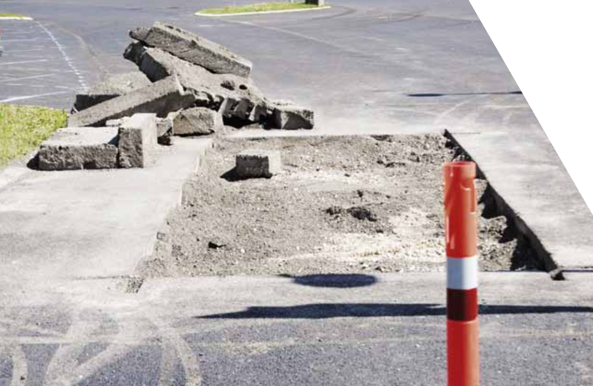
Figur 13 Areal efter optagning af belægningsprøver af SMA 11 40/100-75 fra rasteplass Himmerland Øst (Foto: Colas Danmarks A/S)
