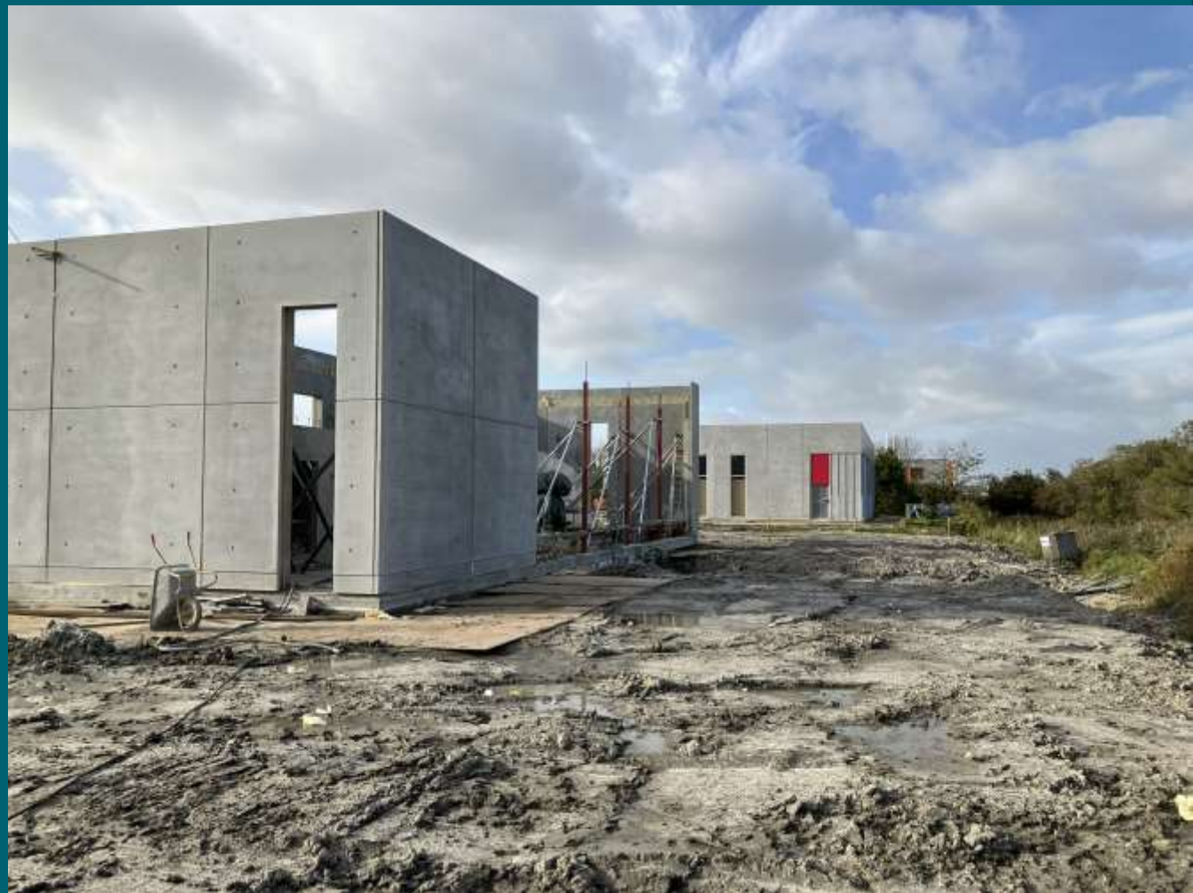
Billede: 6 MW varmepumpe ved Renseanlæg Øst, Aalborg, under etablering 12. oktober 2023
