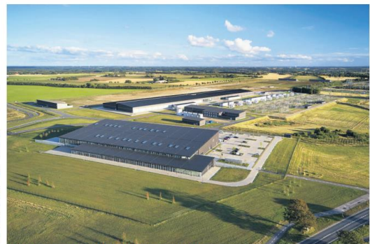
Overskudsvarmen fra Apples datacenter er i flere øre nyt regel om prisloft. Pressefoto.
