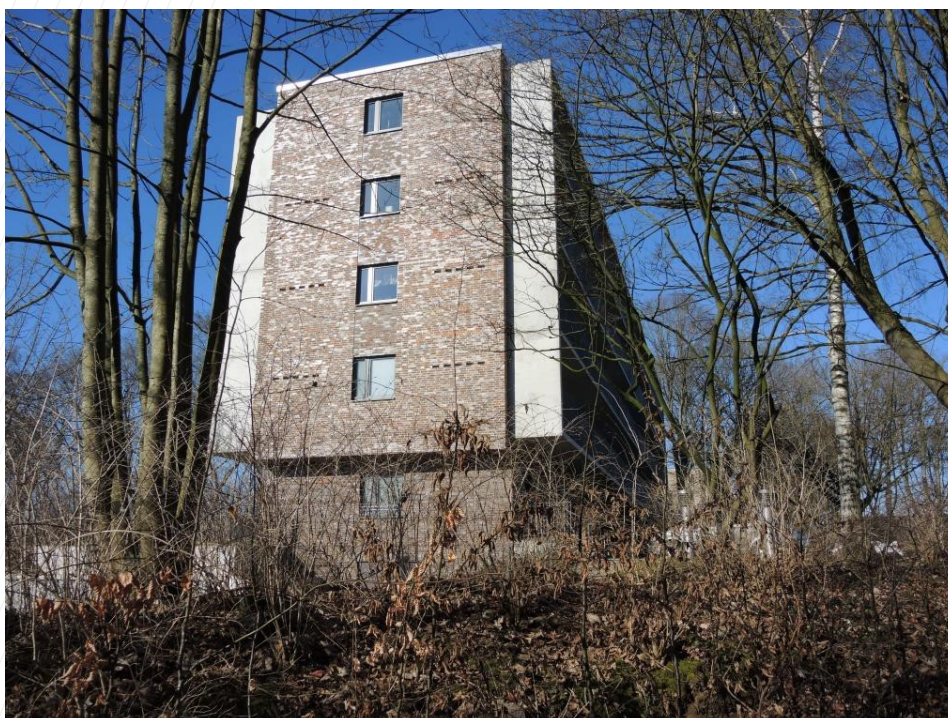
Figur 4.4 Eksempel fra Eckernförde (Tyskland) på åbninger til indbyggede flagermus rastesteder i bygning (Foto: Dorothea Barre).
