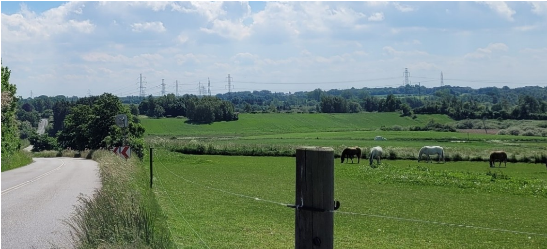
Figur 4.17 Udsigt på tværs af dallandskabet fra nord i retning af Hovegård Højspændingsstation. Det er tydeligt, at landskabet er præget af højspændingsmaster og -ledninger, der tilfører landskabet en betydelig teknisk prægning (Foto: NIRAS A/S).
