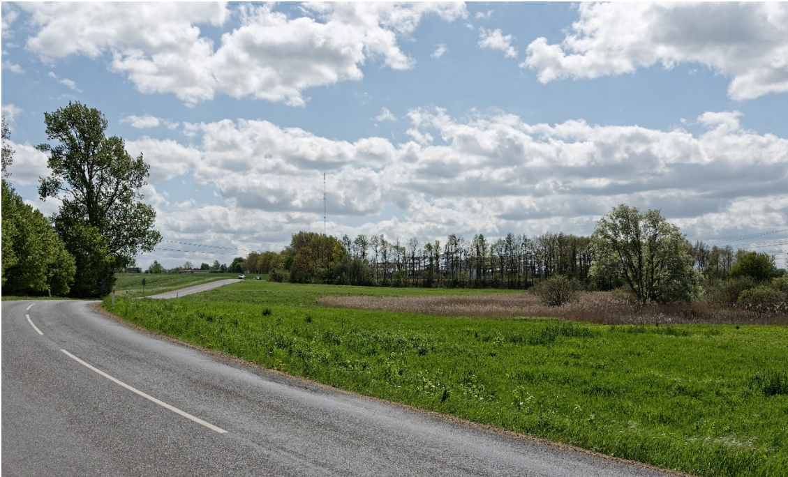
Figur 4.20. Hovegård Højspændingsstation, som den i dag ser ud fra dallandskabet lige nord for stationen. Selve anlægget er i høj grad afskærmet af bevoksning. Mest synlig er den høje telemast, der står i landskabet syd for undersøgelsesområdet (Illustration: NIRAS A/S).
