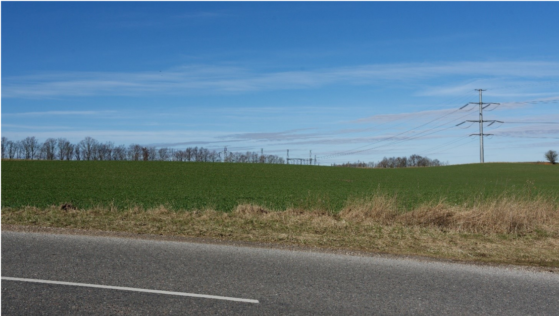
Figur 4.24 I dag er Hovegård Højspændingsstation ikke synlig fra sydøst, idet anlægget er skjult af det bakkede terræn. Kun luftledningerne med tilhørende master indikerer anlæggets tilstedeværelse (Illustration: NIRAS A/S).
