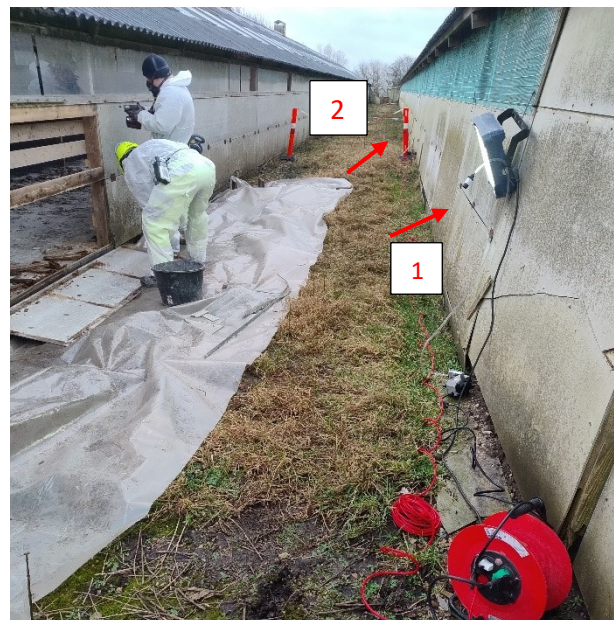
Billede 4—21. Placering af stationære målinger på minkfarm projekt 4. Målingerne er placeret langs den ene side af facaden hvor arbejdet foregik.
