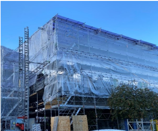
Billede 4—3. Eksempel på fuld overdækning set udefra
