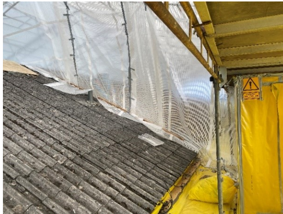
Billede 4—4. Eksempel på arbejdsområde med fuld overdækning set fra adgang til trekamret sluse
