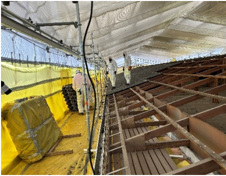
Billede 4—11. Skånsom håndtering af asbestplader
