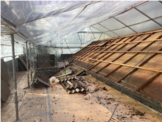
Billede 4—7. Arbejdsområde efter nedtagning af asbestplader – mos med asbest på gulvet – dette er et generelt gængs billede på alle typer projekter.
