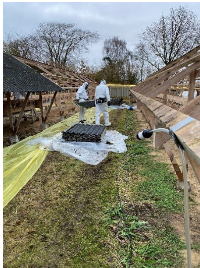
Billede 4—15. Håndtering af asbestholdige tagplader
