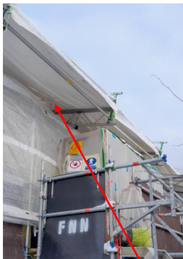
Billede 4—6. Eksempel på arbejdsområde hvor siderne var ikke tætte op mod tagoverdækningen
