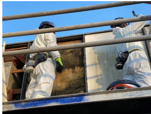
Billede 4—2. Nedtagning af facadeplader fra et rullestillads.
