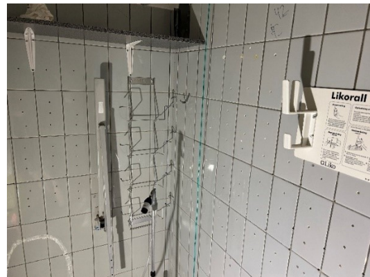
Billede 4—26. Der er udført 344 huller.
