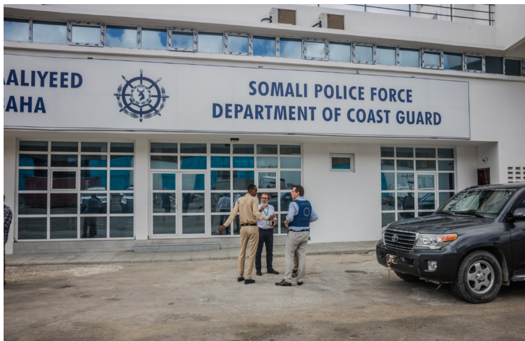
Billede 6: Inspektion af Mogadishus nye hovedkvarter for det maritime politi, et større EUDEL Somalia projekt. Foto: FSB'er Liaison Officer Alexander Borum.
