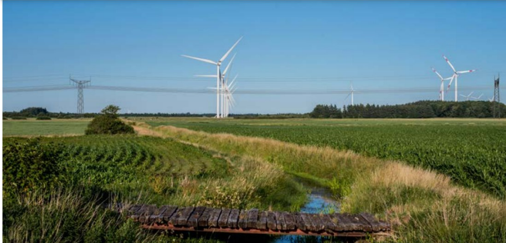
Figur 12. Den danske højspændingsforbindelse nord for grænsen (til venstre) og den tyske højspændingsforbindelse syd for grænsen tilføjer et yderligere teknisk element til landskabet, der i dag er domineret af vindmøller på begge sider af grænsen.
