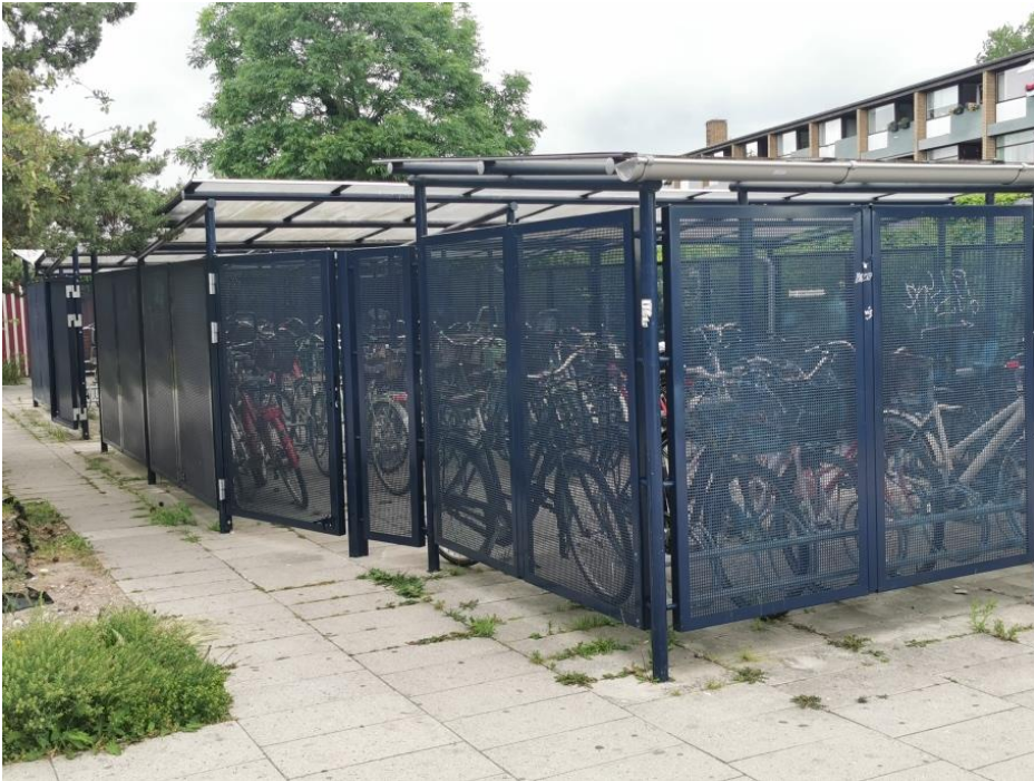
Billede: Tyverisikret og overdækket cykelparkering ved Kastrup Metro Station
