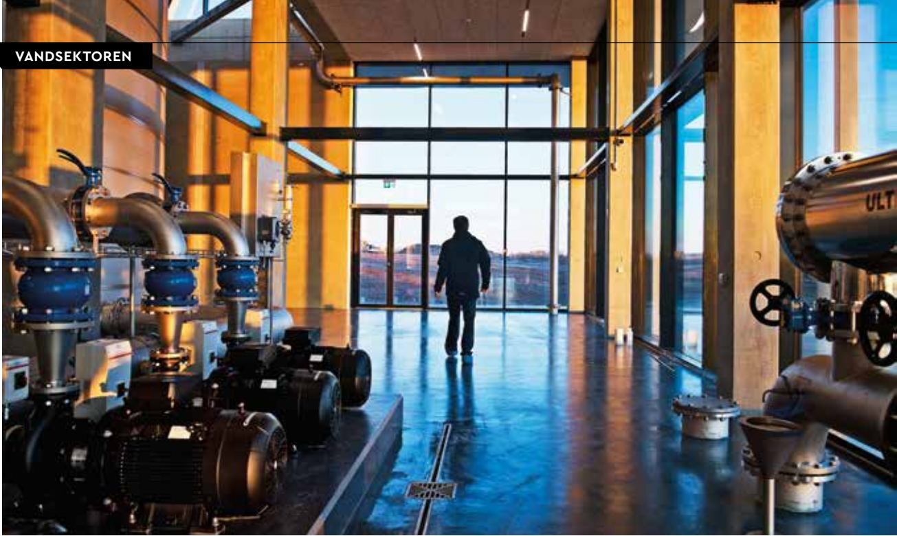
DIN Forsyning har bygget nyt vandværk i Esbjerg. Foto: DIN Forsyning
