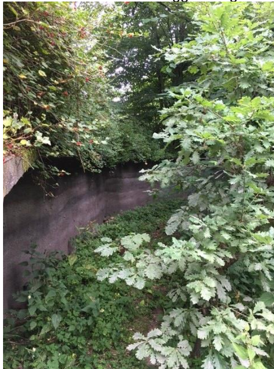
Foto 3. Barriere ved anlæggets bagside
