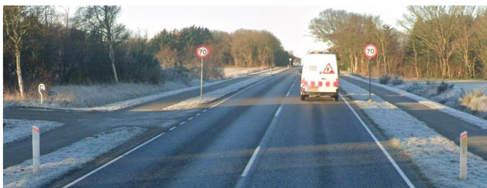
Figur 4-11 Heringvej i km 2,9. Foto fra GoogleMaps.
