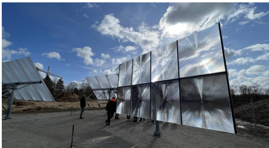
Heliacs andet anlæg i Hørsholm, Danmark. Under opførelse.
