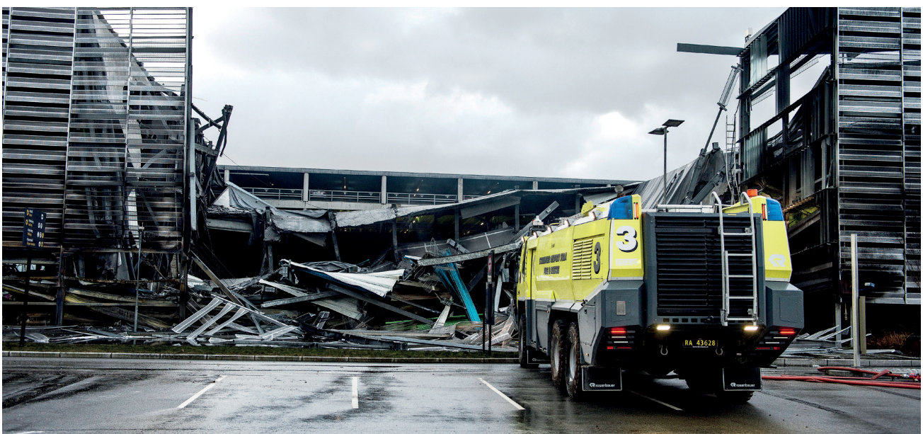
Figur 1. I Stavanger kollapsede et parkeringshus i ubeskyttet stål delvist i marts 2020, efter at en brand spredte sig til mere end 400 biler (foto: Carina Johansen/NTB/Ritzau Scanpix).
