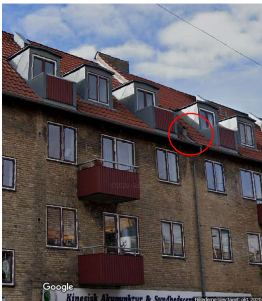
Figur 24 Brandmur (brandvæg) ved tagfod - Foto fra Google street view, okt. 2020.
