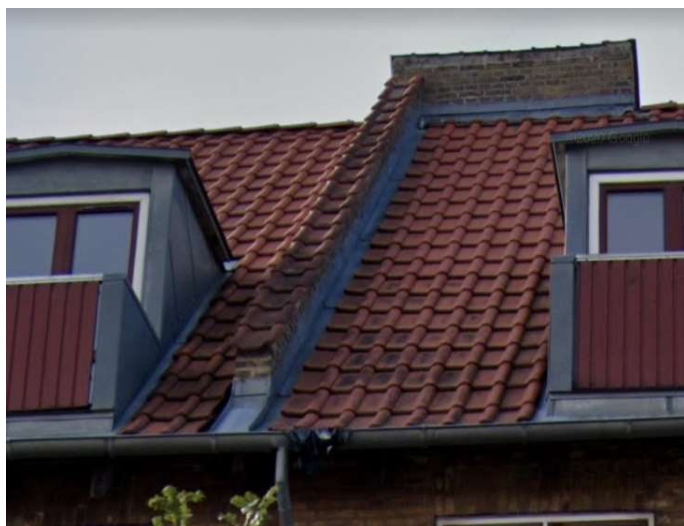
Figur 13 Brandmurens (brandvæg) manglende adskillelse ved tagfod, da underbrædder er ført forbi brandvæggen - Foto fra Google street view. 29
