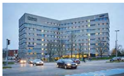
Gladsaxe Company House fra 2015 har energimærke A, men ved at udnytte internetbaseret teknologi med data i høj opløsning kan bygningen blive endnu mere energieffektiv. Foto: NCC.
