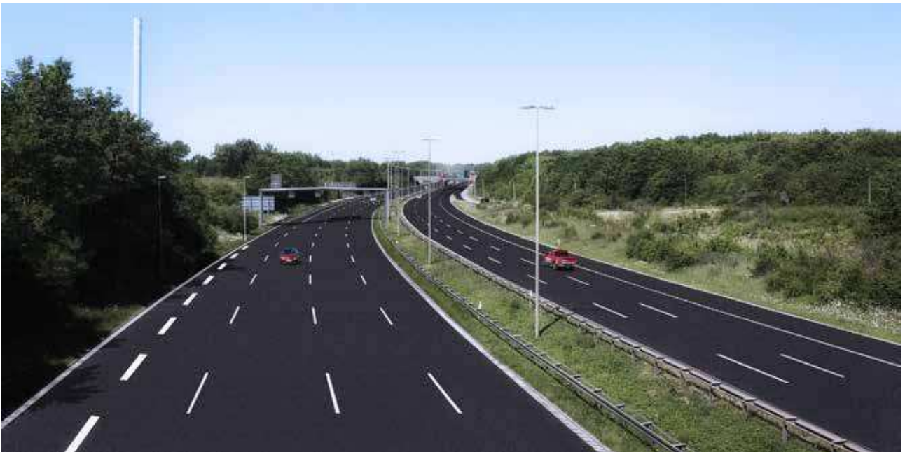
Figur 4.6. Visualisering af udbygningsløsning 1 - Variant B hvor nødsporet alene inddrages til kørsel, når der er behov for det, eksempelvis i myldretiderne. et fra Gammel Køge Landevej mod nord.
