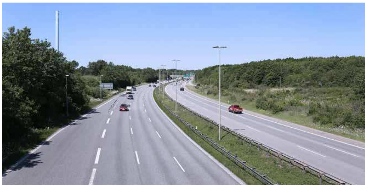
Figur 4.4. Eksisterende forhold. Set fra Gammel Køge Landevej mod nord.
