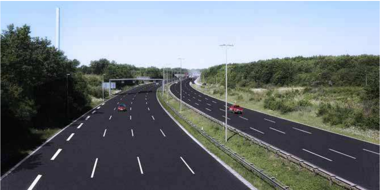
Figur 4.5. Visualisering af udbygningsløsning 1 - Variant A hvor nødsporet inddrages permanent til kørespor således, at der på alle tider er fire kørespor til rådighed i hver retning. Set fra Gammel Køge Landevej mod nord.
