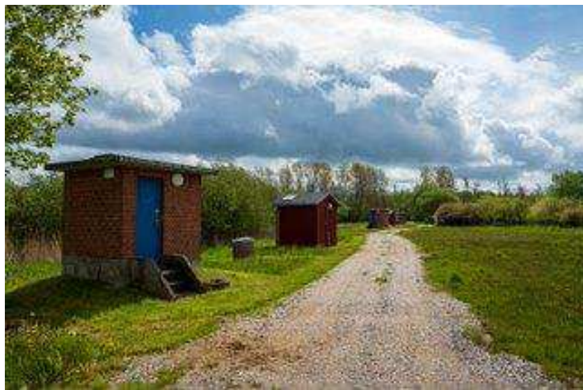
Boringer ved Drastrup vandværk
