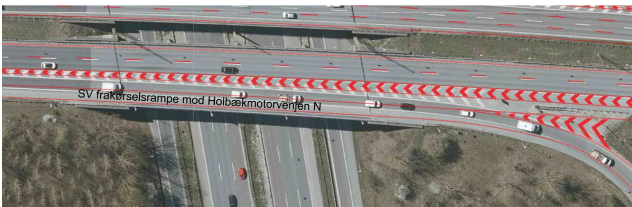
Figur 5.15 Spærrefladen der adskiller de 2 x 2 kørespor ved underføringen af Holbækmotorvejen i nordgående retning.
