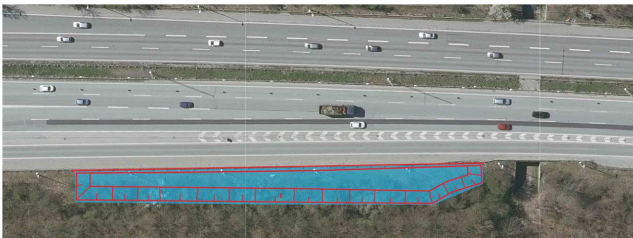
Figur 5.23 Grøftebassin langs Vestvolden.
