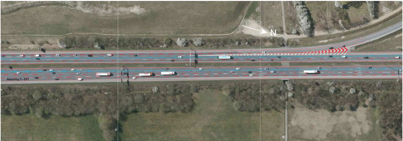
Figur 5.5 "Landvejsafmærkning" anvendt på flettestrækningen umiddelbart syd for Holbækmotorvejen. Køresporet længst til venstre i nordgående retning er forbeholdt gennemkørende trafik mod nord fra Køge Bugt Motorvejen. Køresporene længst til venstre i sydgående retning er lukket for 'sidste øjeblikks' kørebaneskift mod Køge Bugt Motorvejen, mens indflettende trafik fra Holbækmotorvejen gerne må flette, hvis der er plads (blå stribe).
