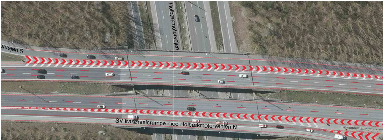
Figur 5.12 Passagen ved Holbækmotorvejen i sydgående retning.
