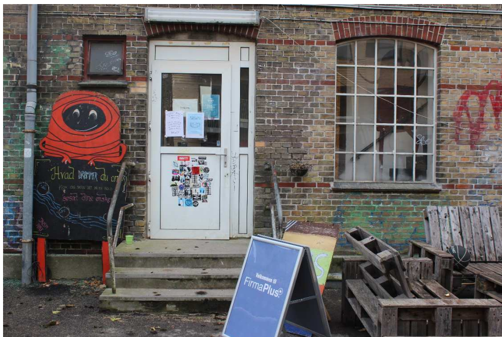
FIGUR 11. Den sekundære indgang til INSP! Her etableres en trappelift, som giver adgang til bygningens handikaptoilet.
