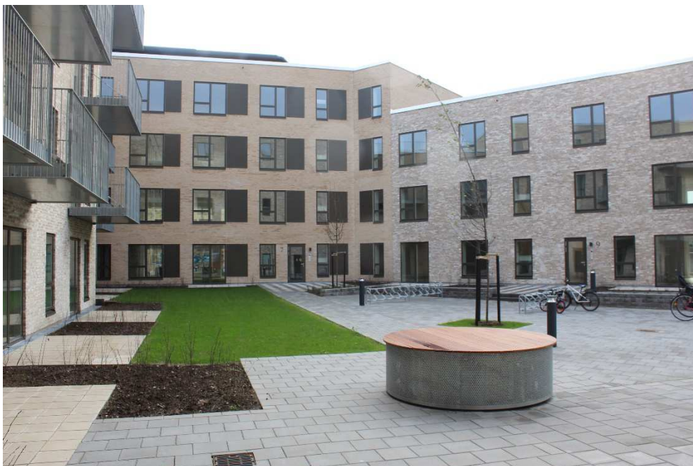
FIGUR 8. En af udluftningskanalerne.
