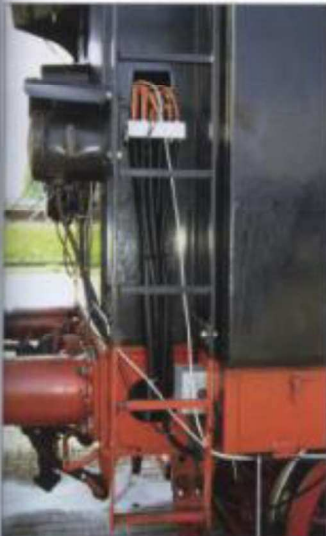
De bekabeling van alle attributen naar de centrale ATB-E-kast wordt aan de zijkant de tenderkast ingevoerd. Nu nog provisorisch, straks valt niemand deze uitgebreide kabelbos nog op.
