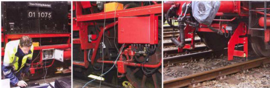
Links: Ronald Hagenaar van Lloyd's Register kalibreert met behulp van zijn computer de ATBE-installatie van SSN-loc 01 1075. Deze is ingebouwd in het geopende kastje; 5 mei 2009. Midden: zo zit de centrale apparatuurkast er in gesloten toestand uit. Deze valt nauwelijks op. Uit de kast lopen een aantal kabels en leidingen naar de diverse opnemers, kleppen en de snelheidsmeter. Kunt u zich voorstellen dat het een hele klus geweest is om te bedenken hoe een en ander netjes en zo onopvallend mogelijk aangebracht kon worden? Rechts: de spoelen voor het opnemen van de ATB-signalen op de tender van loc 01 1075. Deze moeten vóór de voorste wielen zijn aangebracht.
