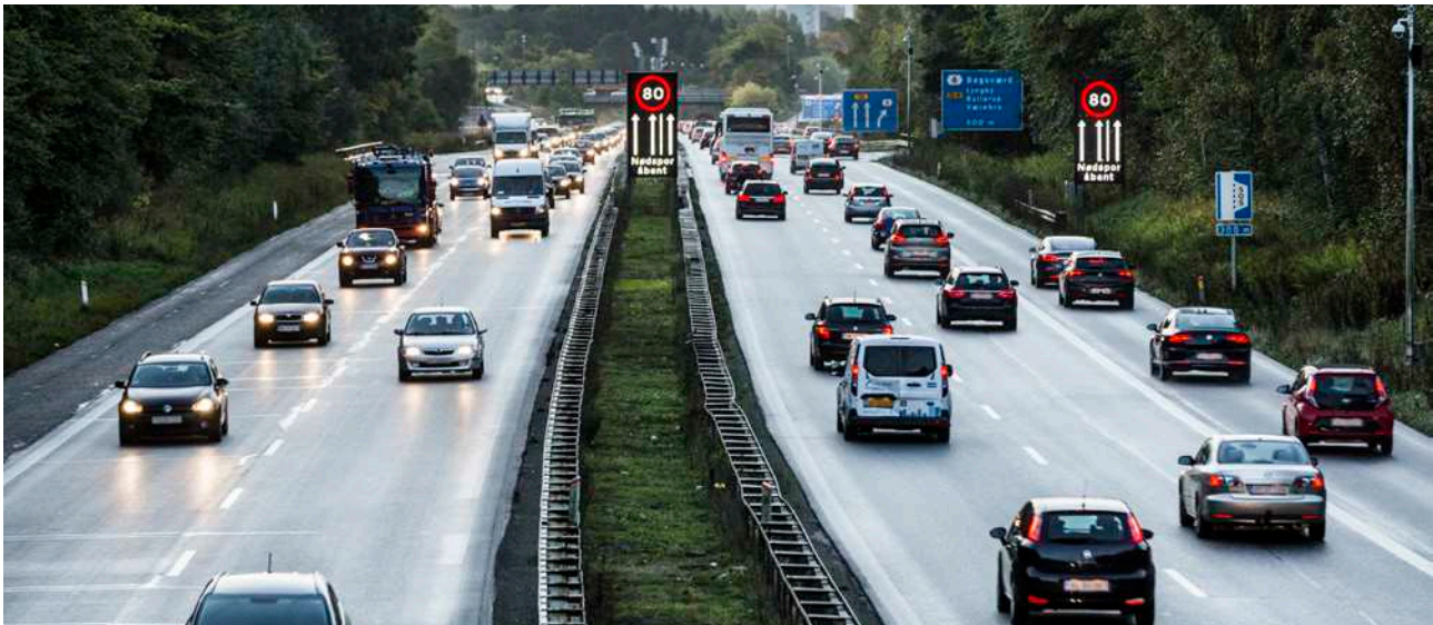
ITS-system ved kørsel i nødsporet på Hillerødmotorvejen.
