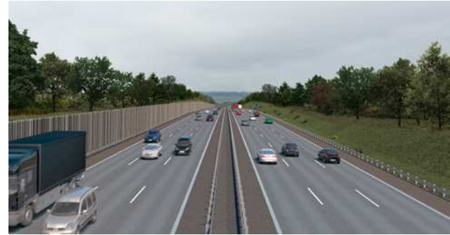
Visualisering af udbygget motorvej med støjskærm
