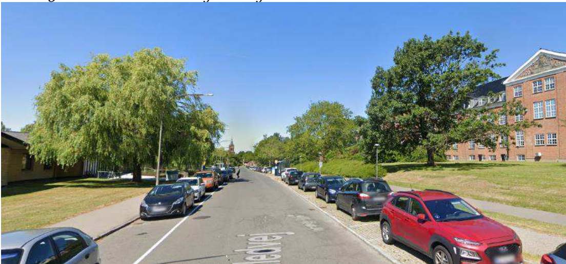
Billede 5: Den røde delstrækning- vestlig del
