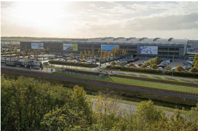
Ø-perron (overgang til højre i billedet)
