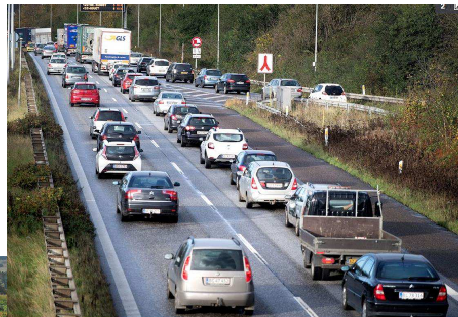
Det evige smertensbarn, motorvejen ved Limfjordstunnelen, er nu oppe på en døgntrafik på 80.000 køretøjer. Arkivfoto: Torben Hansen
