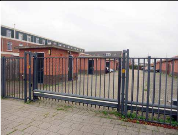
Rækkehuskarré set fra Timor gaden. Stakit med en stor låge til biler og en mindre til fodgængere og cyklister (NB! tæt ved bydelscentrum). Gården er til parkering - stor og øde - og med opbevaringsskure.
