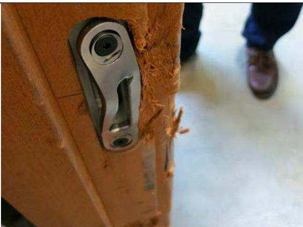
Ødelæggelse efter indbrudstest. Det gælder om at ødelæggelsen skal tage mindst 3 minutter, hvis man ønsker skalsikring i EN klasse 2, og 5 minutter i klasse 3.
