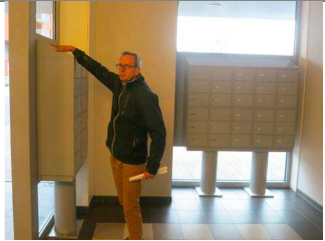
Postkasser i etageejendom i Oosterheem. Postbuddet har kun adgang fra ydersiden, beboerne kun fra indersiden. Skrå flade for oven for at undgå papiraffald. Fra 2015 kræver PKVW ikke skrå flader.
