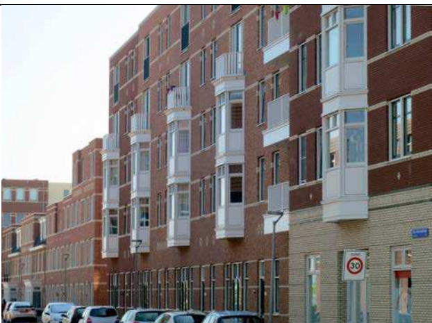
Sidegade til Europalaan med karnapper, så man fra boligerne kan se langs med gaden.
