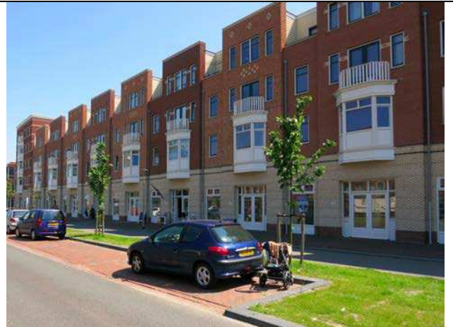
Europalaan, sydsiden. Godt udsyn til parkering, brede fortove, virksomheder i gadeplan. Sidst-nævnte har dog ført til, at der langs denne hovedgade ingen trappeopgange er til boligerne.
