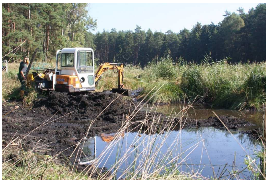
Figur 3.18. Bortgravning af stærkt nedbrudt tørv i en minerotrof mose før den vådlægges igen. Lokaltet: Lehstsee-Niederung i delstaten Brandenburg, nordøst Tyskland (Zak et al. 2017).
