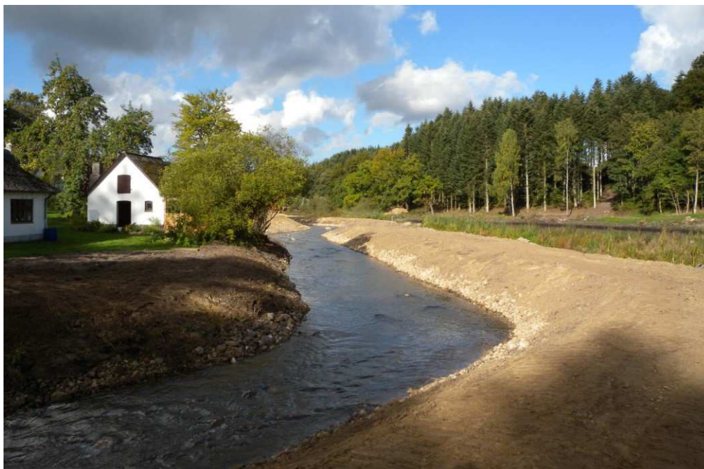
Matstrup Å, Horsens Kommune. Mølleopstemning er fjernet ved at udligne faldet for opstemningen. Foto: Tony Bygballe.
