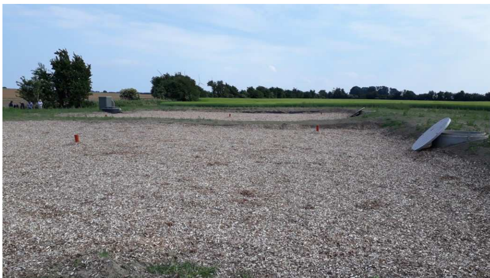
Minivådområde med filtermatrice ved Gyldenholm Gods, Slagelse. Forskningsanlæg med tre bassiner med henblik på test. Foto: Susanne Brusvang Hjulær.
