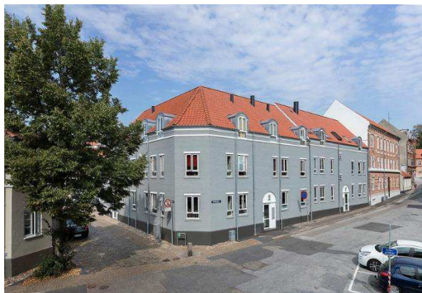
Nypudset facade samt nye teglsten på taget
