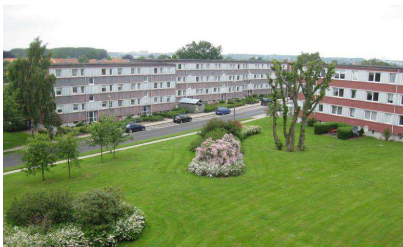
Bebyggelsen med fri-/udearealer før renovering
