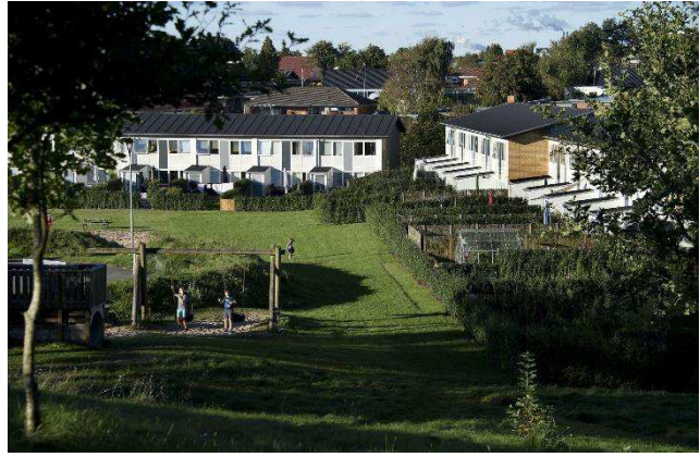
Nye facader og indgangspartier samt nye vinduer
