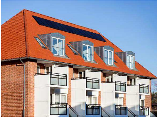
Nyt tag med kviste og renoverede altaner på gårdsiden
