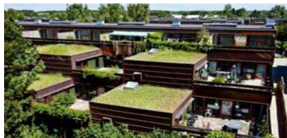
Nye tage på lavhusene efter renovering og isolering
