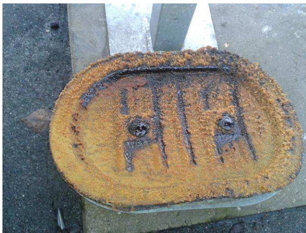
Fedt aflejring på inspektionslemme Ikke rengjort i 1 år
