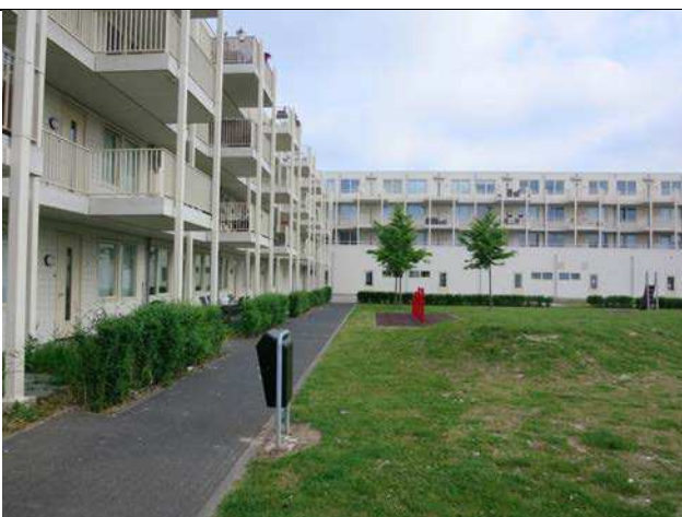
Den midterste karré set mod nord. Virksomhederne i bunden bag i billedet vender på den anden side ud mod Europalaan. Alle øvre etager på dette billede har altangangsadgang. Der er dog udepladser der.
