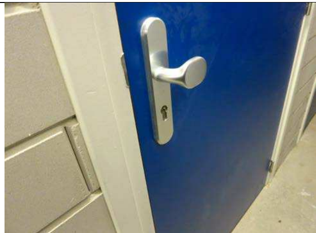
Hvert opbevaringsrum har en sikker dør og en sikker lås - her dog uden beskyttelse mod cylindertræk.
