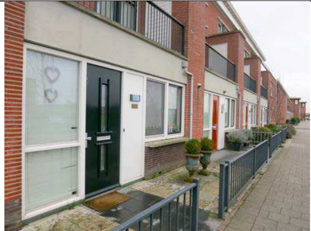
Rækkehusfacade mod Tasmanië gaden i Oosterheem i samme karré som til venstre. Forhaver og lavt stakit giver beskyttelsesdistance. Døre og vinduer er skalsikrede til og med 1. sal.
