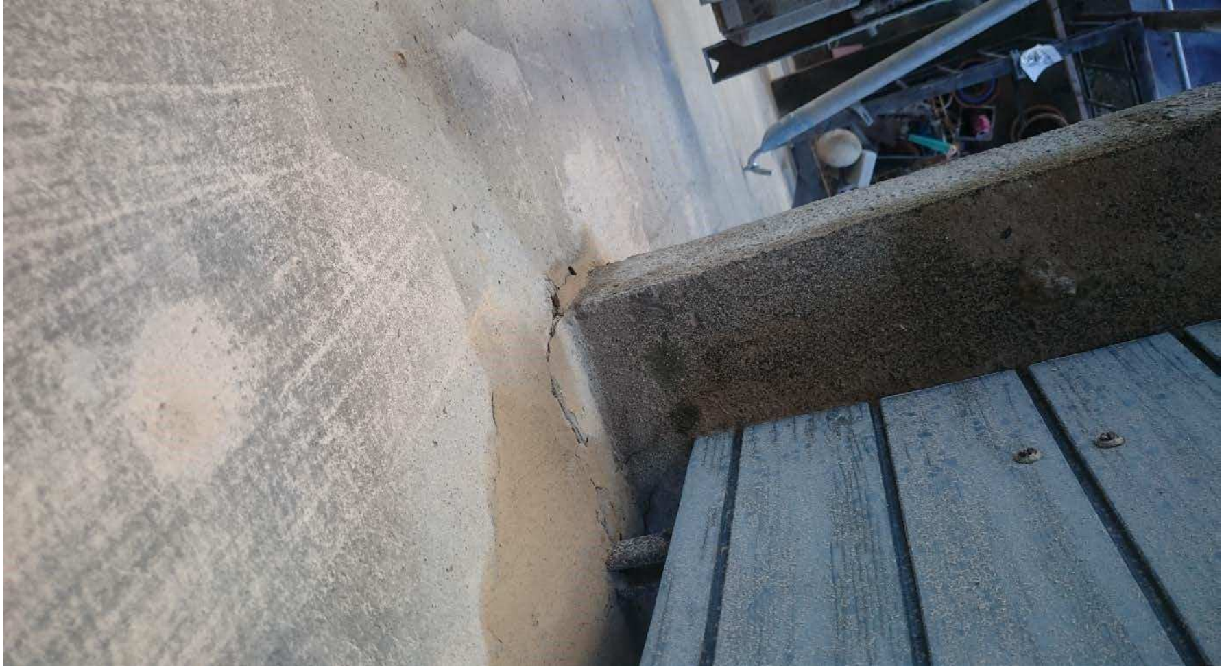
Facade over altan til venstre
