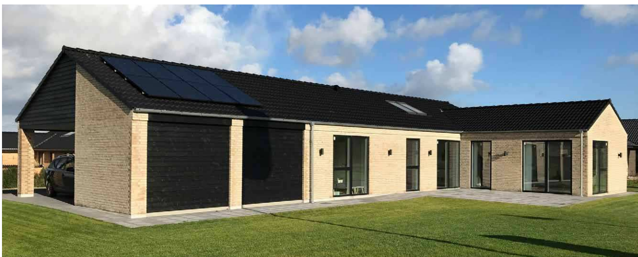
Typisk typehus opført til lavenergiklasse 2015.
