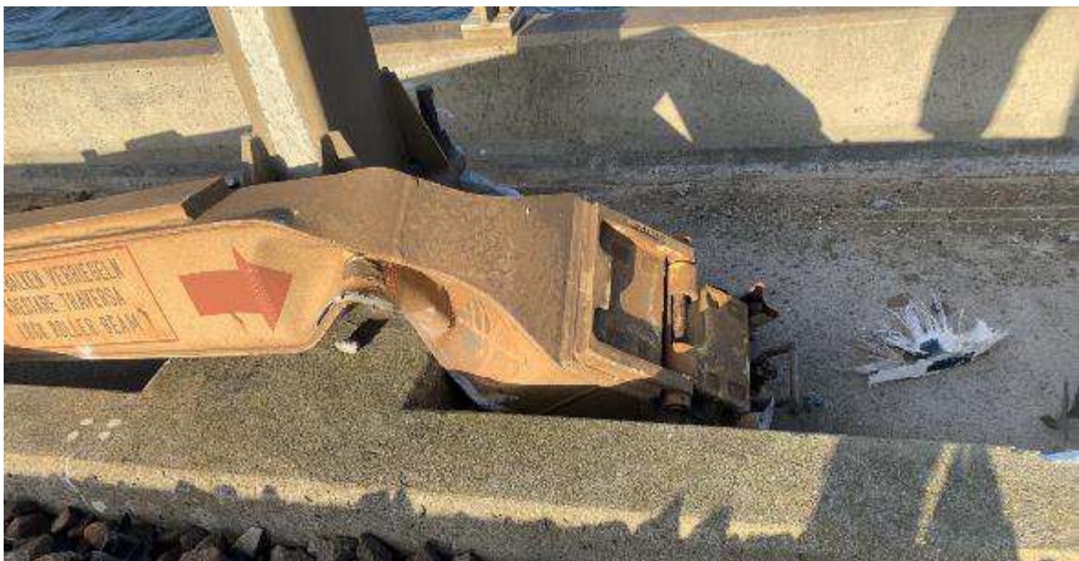
Figur 39: Km 127,450 Containerbom fra lomnevognen ved køreledningsmast. IC 4 beklædning.
