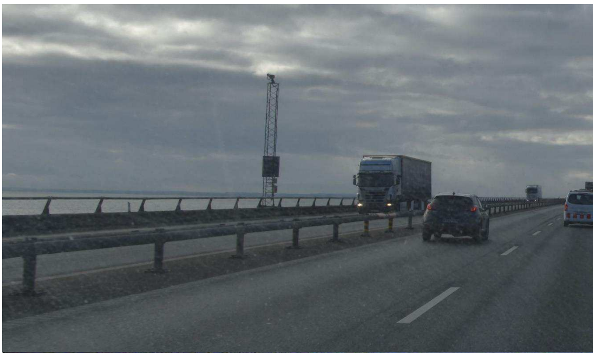
Figur 114: Videokamera på Vestbroen - tæt ved ulykkesstedet
