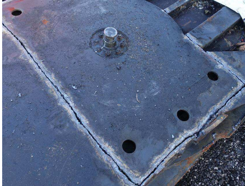
Figur 47: Udsækning af skammelstykke med hovedbolt
