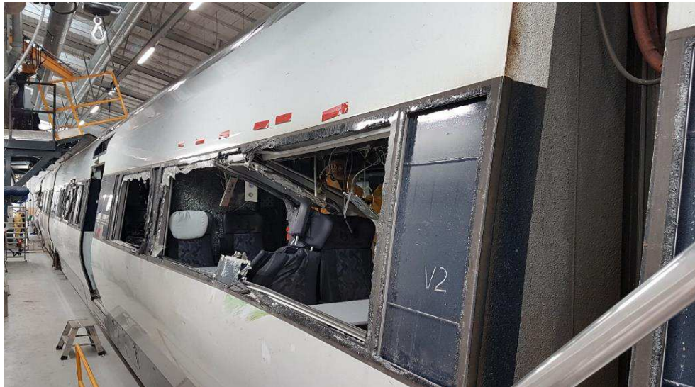
Figur 86: Vinduesstolpe trykket ind mellem vindue 2 og 3
