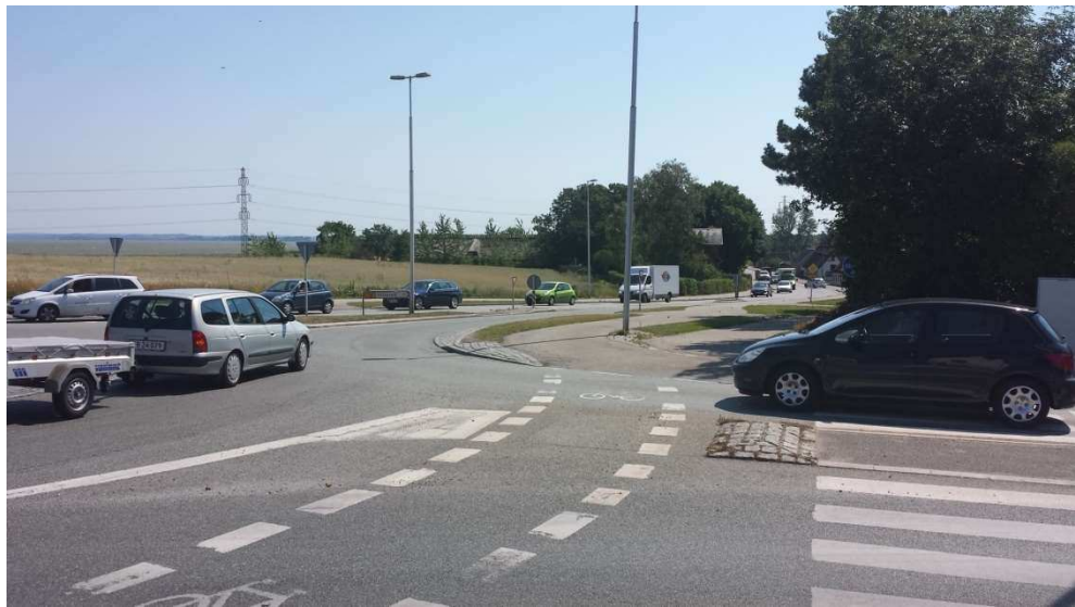
Figur 7 Billede taget på det vestlige hjørne ved Frederikssundsvej i retning mod Hillerød sydøst. Det ses, at der ankommer en del trafik fra Hillerød, men at der kun anvendes et kørespor i tilfarten. Bilen med trailer anvender delvis det overkørbare areal, grundet den forholdsvis lille midterø i rundkørslen.
