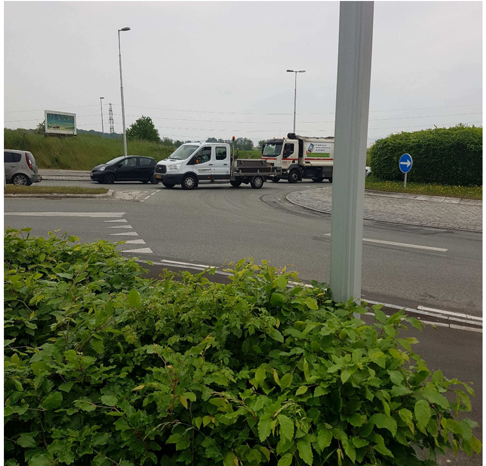
Figur 3.2 Rundkørslen set mod nord / nordøst med Hillerødvej nordvestlig vejgren mod venstre.
