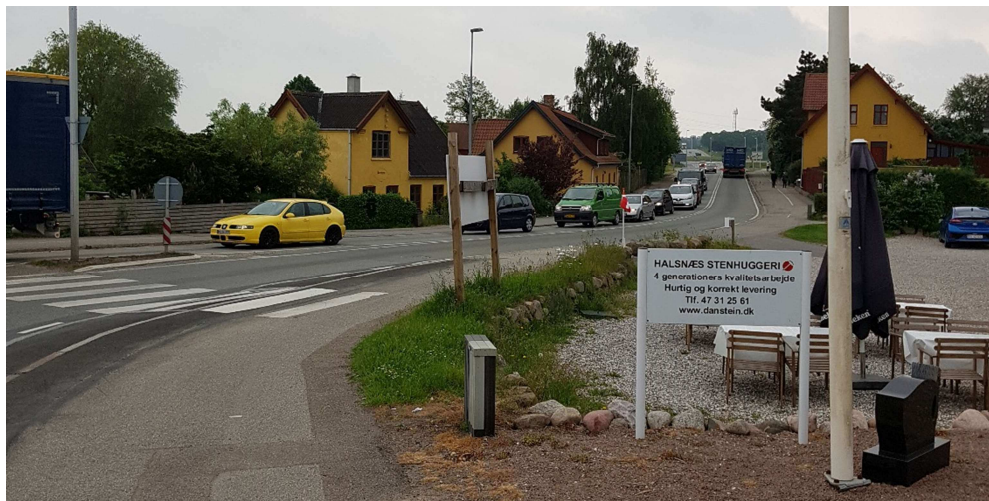
Figur 3.9 Eksempel på køproblem på Frederikssundsvej om eftermiddagen pga. trafikafviklingsproblemer i rundkørslen. Foto er taget i sydøstlig retning.
