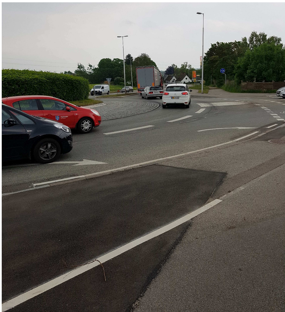
Figur 3.1 Foto af rundkørslen taget fra det vestlige hjørne mellem den nordvestlige gren på Hillerødvej og den sydlige gren (Frederikssundsvej) set mod sydøst. Cirkulationsarealet er her 2-sporet.
