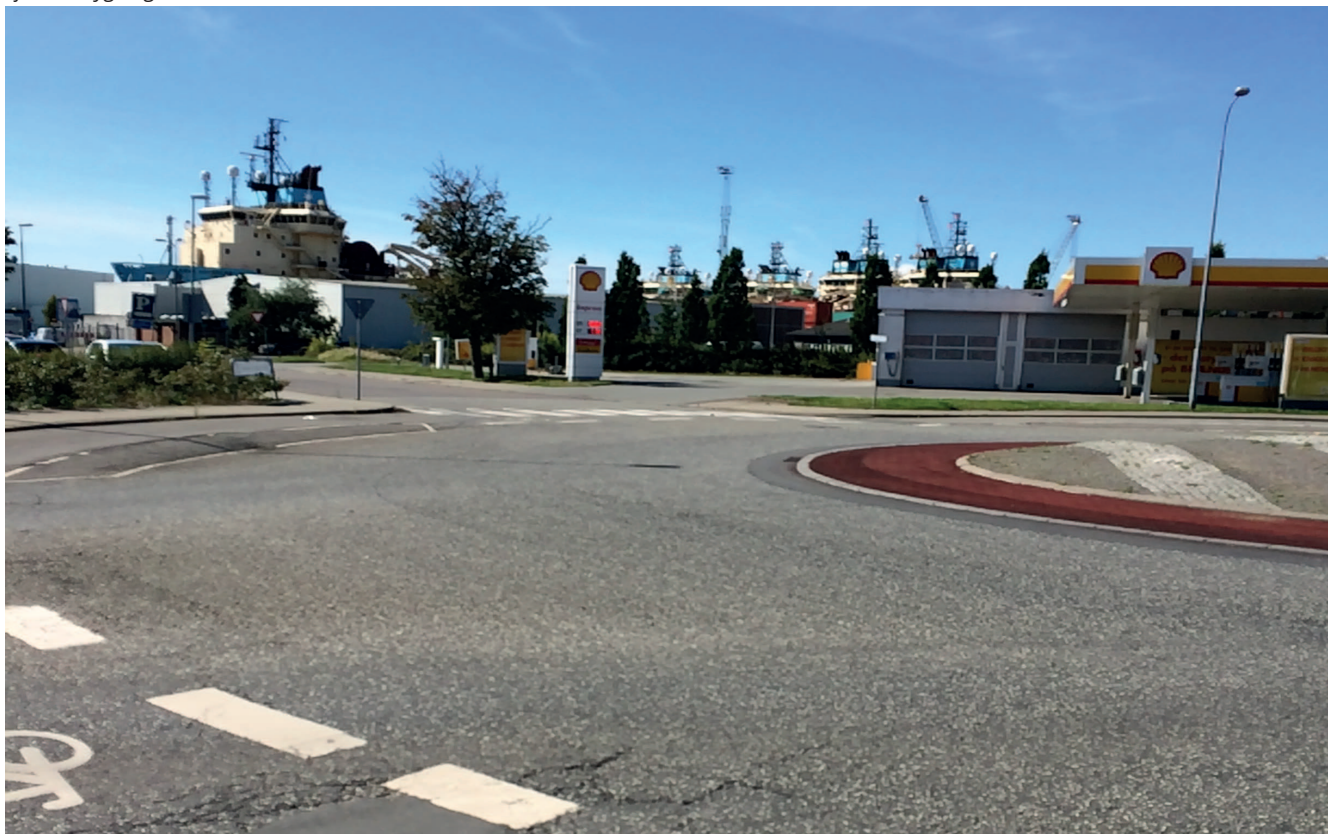
Foto af rundkørslen ved Norgesgade / Holstensvej / Oldenborggade efter ombygning.
