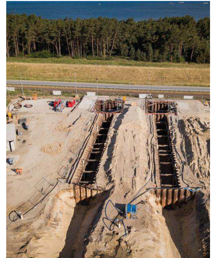
700 meter lange mikrotunneler forbinder rørledningen til landsidefaciliteter i Tyskland
