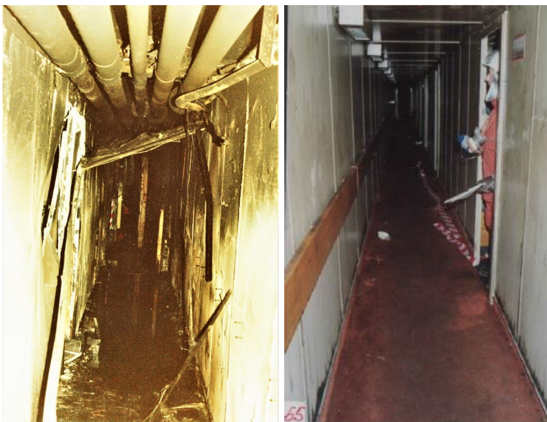
Figur 78 - Bilde fra nevnte korridor på Dekk 4 tatt 10.april 1990. På bildet så kan man ikke se at det er noen synlig diesel i slokkevannet på gulvet i korridoren. Man kan heller ikke se noen høy temperatur skader. Bildet til høyre viser en generell korridor som er tilnærmet upåvirket av brann for å gi et bilde hvordan en slik korridor typisk så ut før brannen»
