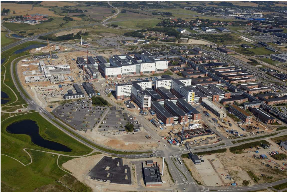
Luftfoto af DNU i august 2016. Til højre ses det eksisterende sygehus, og midt i og mod venstre ses udbygningen.
