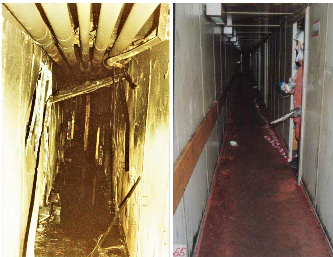
Figur 78 - Bilde fra nevnte korridor på Dekk 4 tatt 10.april 1990. På bildet så kan man ikke se at det er noen synlig diesel i slokkevannet på gulvet i korridoren. Man kan heller ikke se noen høy temperatur skader. Bildet til høyre viser en generell korridor som er tilnærmet upåvirket av brann for å gi et bilde hvordan en slik korridor typisk så ut før brannen»
